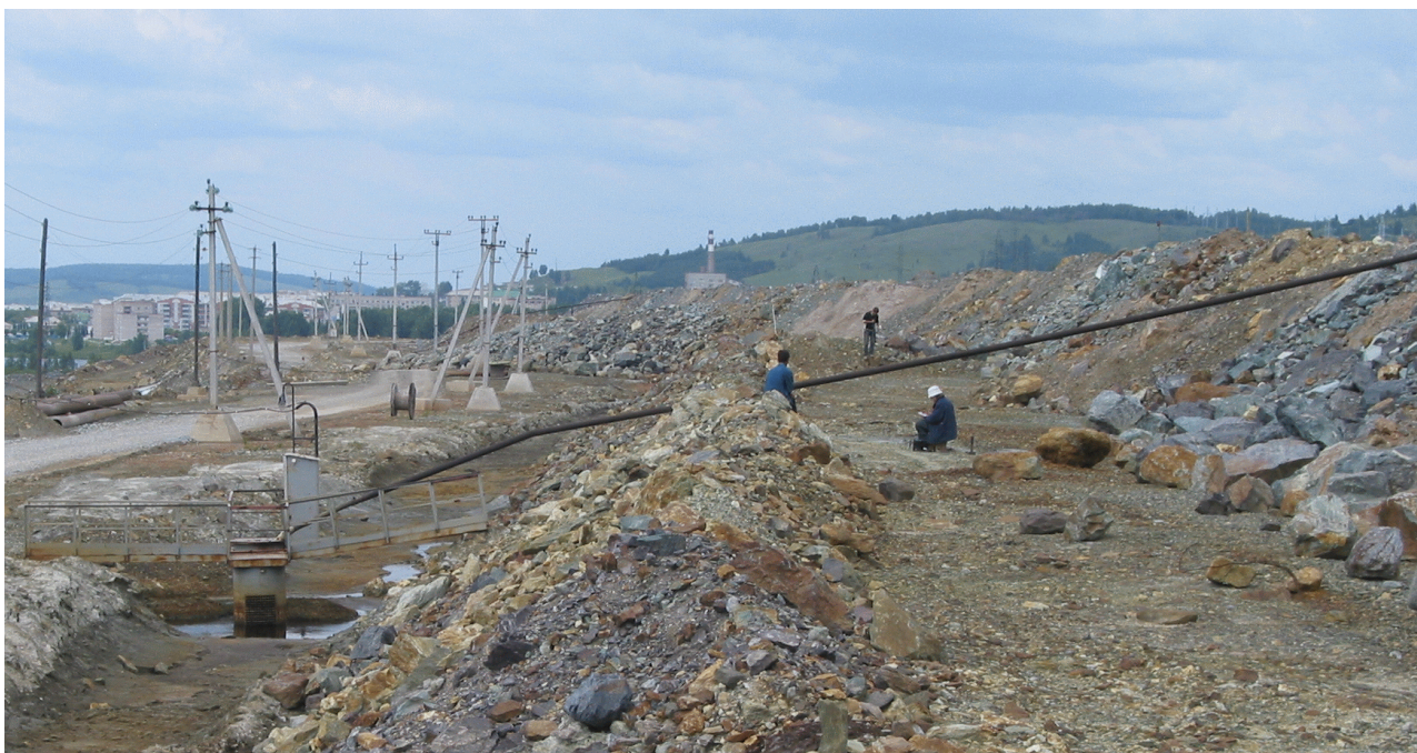
Рис.1. Вертикальные электрические зондирования на пятом уровне дамбы.
